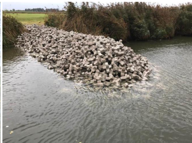
Afbeelding 3. Pilot: Flexibele krib met X-stream blokken.
