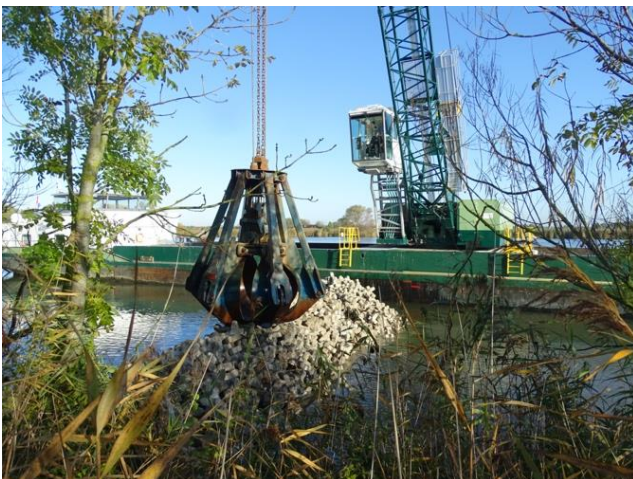
Afbeelding 2. Pilot: Flexibele krib met X-stream blokken.
